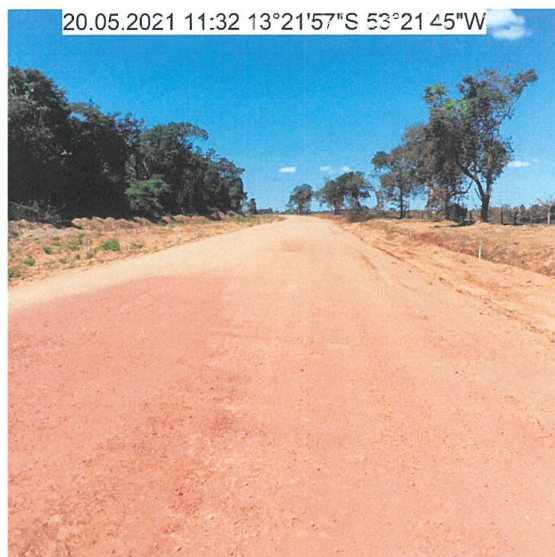
FOTO 26: ASPECTO DE TRECHO EM TERRENO NATURAL COM LIMPEZA LATERAL - km 25,3
