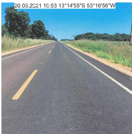
FOTO 12: TRECHO COM REVESTIMENTO EM TSD E SINALIZAÇÃO IMPLANTADA – km 8,6
