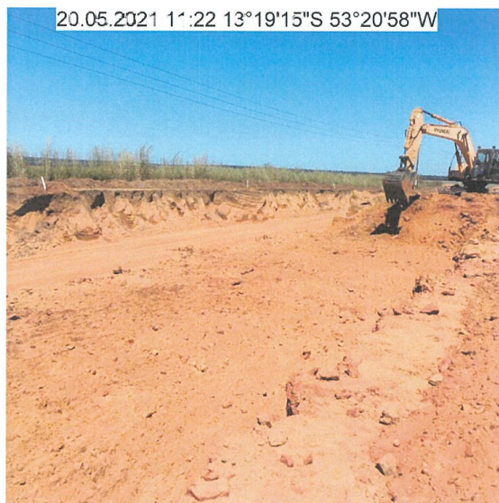
FOTO 23. ASPECTO DO TRECHO EM TERRAPLENAGEM - km 18,8
