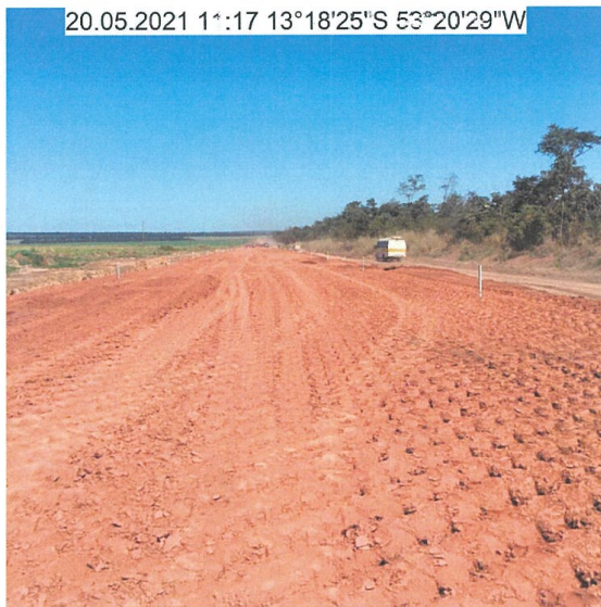
FOTO 21: TRECHO EM TERRAPLENAGEM COM COMPACTAÇÃO DE ATERRO – km 17,8
