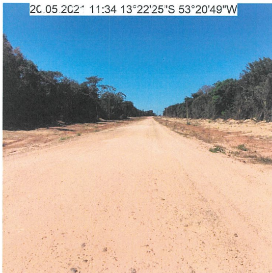
FOTO 27: ASPECTO DE TRECHO EM TERRENO NATURAL COM LIMPEZA LATERAL - km 27,2
