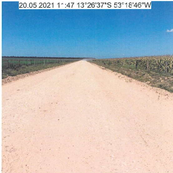
FOTO 30. ASPECTO DE TRECHO EM TERRENO NATURAL - km 37,1
