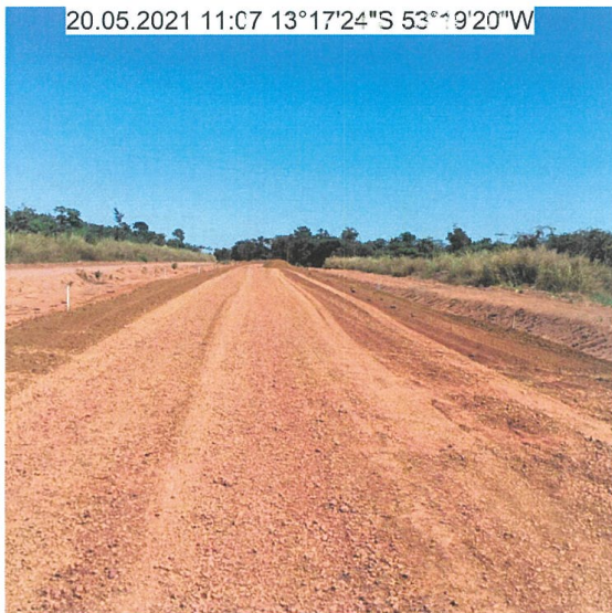
FOTO 18: TRECHO COM COMPLEMENTAÇÃO DE MATERIAL PARA CAMADA DE BASE - km 15,0
