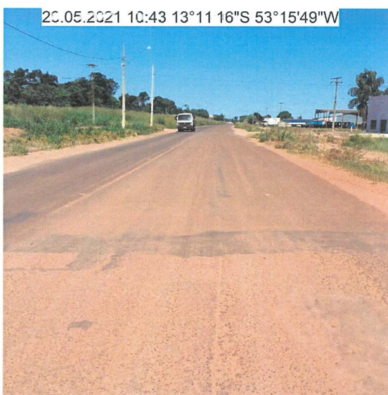
FOTO 8: INÍCIO DO TRECHO COM REVESTIMENTO EM TSD E SINALIZAÇÃO IMPLANTADA – km 0,7
