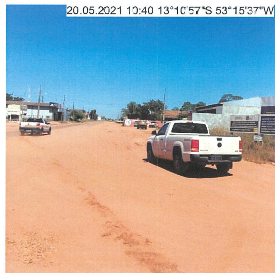
FOTO 2: INÍCIO DO TRECHO ENTR. MT 242 EM GAÚCHA DO NORTE - km 0,0
