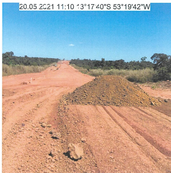
FOTO 19. TRECHO COM COMPLEMENTAÇÃO DE MATERIAL PARA CAMADA DE BASE – km 15,8
