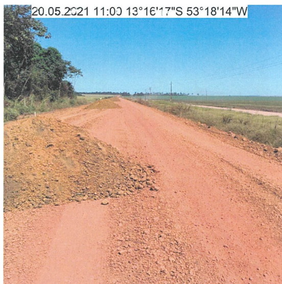
FOTC 15: TRECHO COM COMPLEMENTAÇÃO DE MATERIAL PARA CAMADA DE BASE – km 12,1
