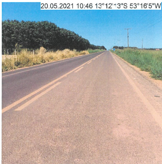
FOTO 9: TRECHO COM REVESTIMENTO EM TSD E SINALIZAÇÃO IMPLANTADA - km 2,6
