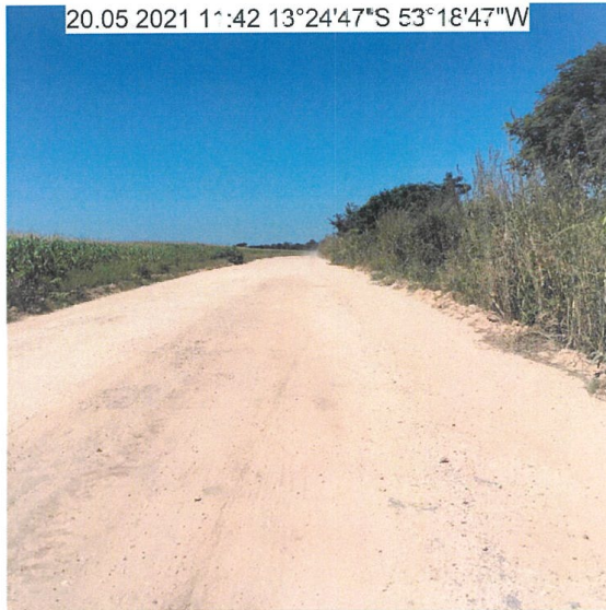
FOTO 29. ASPECTO DE TRECHO EM TERRENO NATURAL - km 33,1
