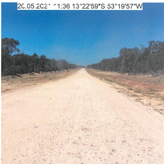
FOTO 28: ASPECTO DE TRECHO EM TERRENO NATURAL COM LIMPEZA LATERAL - km 29,1
