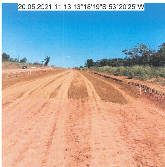
FOTO 20. INÍCIO DE TRECHO COM FORRO DE MATERIAL PARA A SUB-BASE – km 16,8
