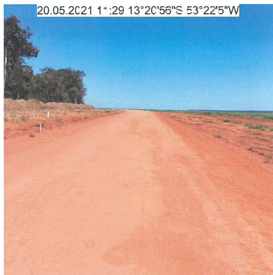
FOTO 25: ASPECTO DE TRECHO EM TERRENO NATURAL COM LIMPEZA LATERAL - km 23,3
