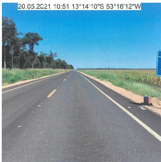
FOTO 11: TRECHO COM REVESTIMENTO EM TSD E SINALIZAÇÃO IMPLANTADA – km 6,6
