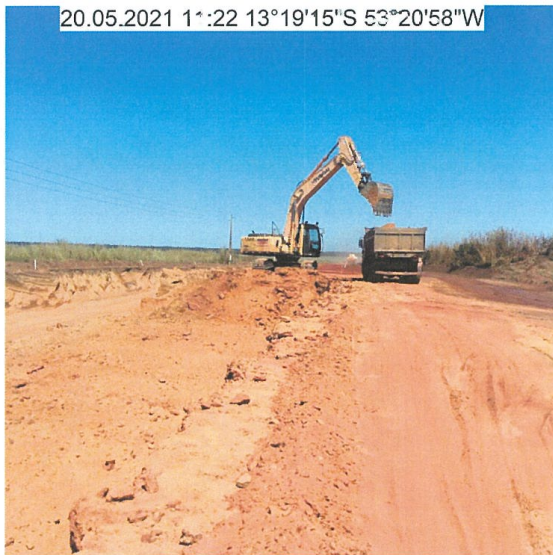
FOTO 22: ASPECTO DO TRECHO EM TERRAPLENAGEM – km 18,8
