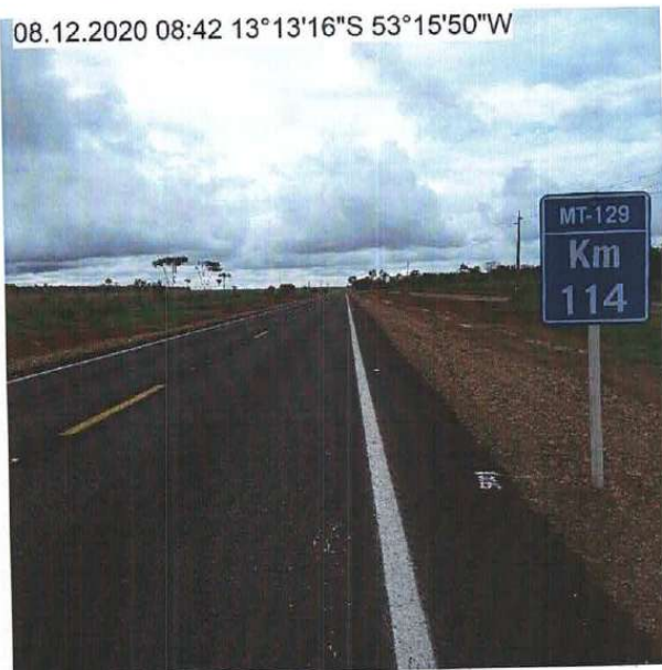
FOTO 15: TRECHO COM REVESTIMENTO EM TSD E PLACA DE INDICAÇÃO – km 4,7
