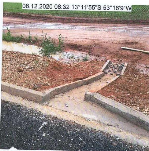
FOTO 10: DETALHE DE SAÍDA, DESCIDA E DISSIPADOR D'ÁGUA EXECUTADA - km 2,0
