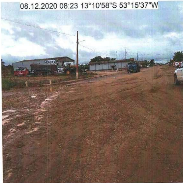
FOTO 3: INÍCIO DO TRECHO ENTR. MT242 EM GAÚCHA DO NORTE - km 0,0
