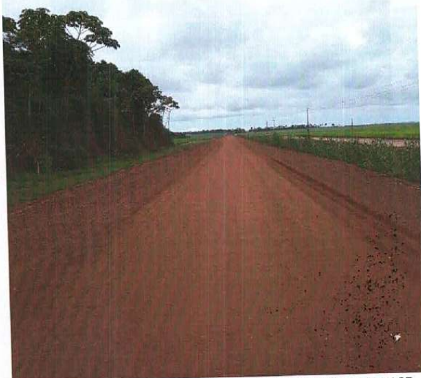
FOTO 27: ASPECTO DO TRECHO COM FORRO DE SUB-BASE - km 12,2
