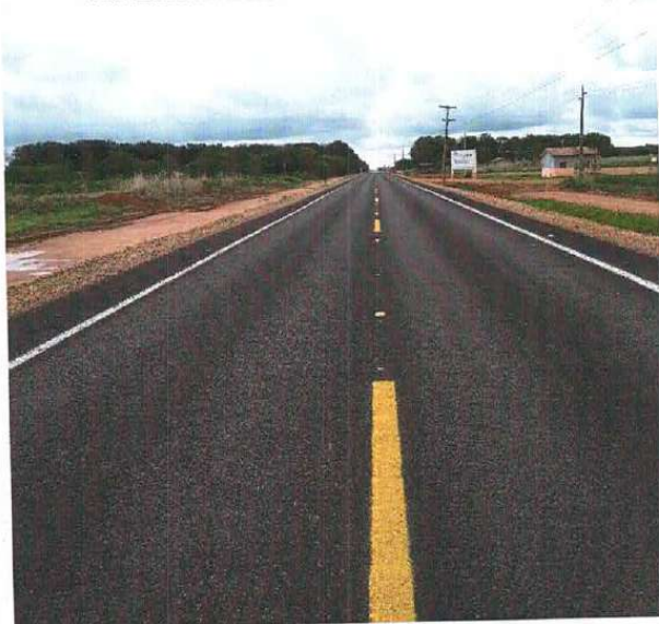
FOTO 11: TRECHO COM REVESTIMENTO EM TSD E SINALIZAÇÃO IMPLANTADA – km 3,0
