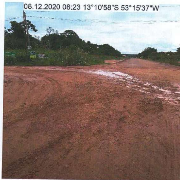
FOTO 2: INÍCIO DO TRECHO ENTR. MT242 EM GAÚCHA DO NORTE (ÂNG. INVERSO) – km 0,0
