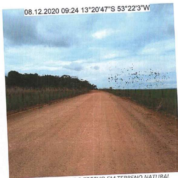
FOTO 36: ASPECTO DO TRECHO EM TERRENO NATURAL – km 23,0
