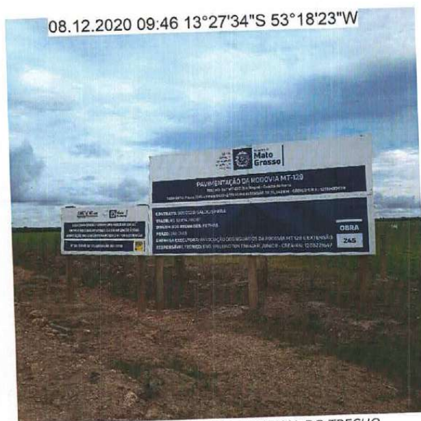
FOTO 44: PLACA DA OBRA NO FINAL DO TRECHO - km 39,0
