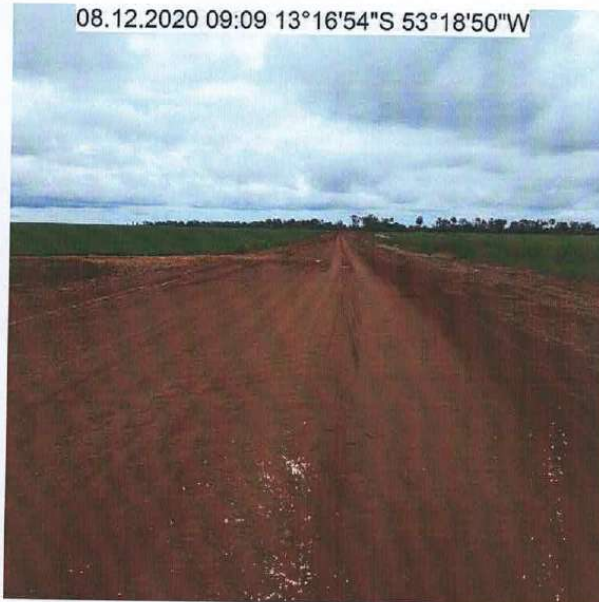
FOTO 29: TRECHO EM TERRAPLENAGEM - km 13,7
