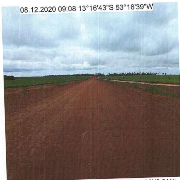
FOTO 28: ASPECTO DO TRECHO COM FORRO DE SUB-BASE - km 13,3
