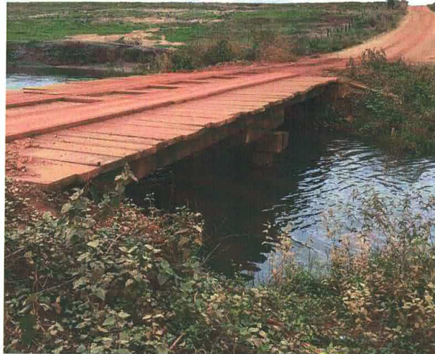
FOTO 25 – PONTE DE MADEIRA DA ESTACA 4860
