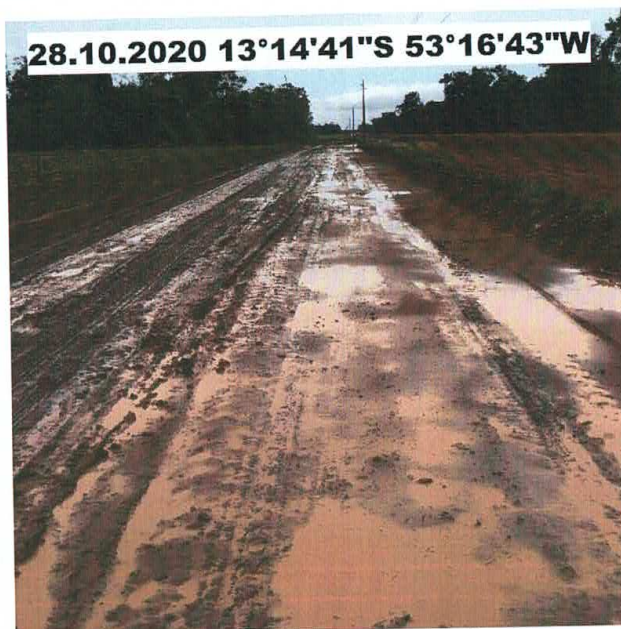
FOTO 11 – DESVIO EM CONDIÇÕES PRECÁRIAS DEVIDO ÀS RECENTES CHUVAS, SERÁ REALIZADA A MANUTENÇÃO
