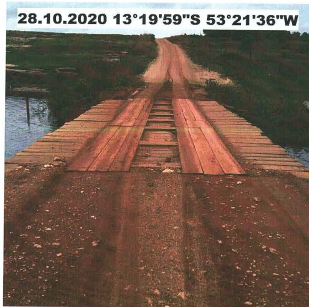
FOTO 24 – PONTE DE MADEIRA DA ESTACA 4860
