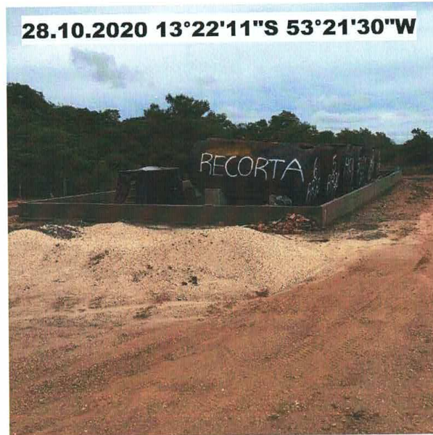
FOTO 21 – CANTEIRO DE OBRAS EM CONSTRUÇÃO
