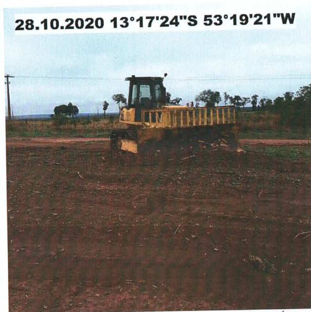
FOTO 5 – LIMPEZA E DESMATAMENTO CONCLUÍDO
