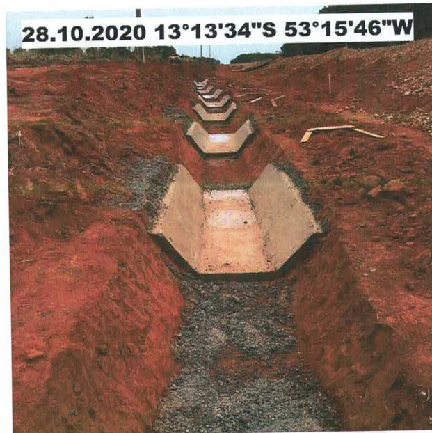
FOTO 20 – EXECUÇÃO DE VALETAS DE PROTEÇÃO DE ATERRO
